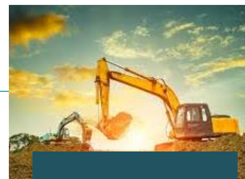
Serviços de Construção
